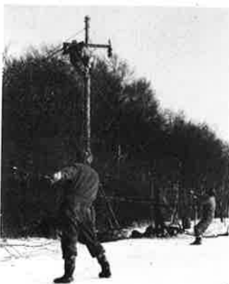
K&L's luftledningsmontører igang med retablering af en 10 kV-luftledning efter vejrgudernes overfald den 3. og 4. januar.
