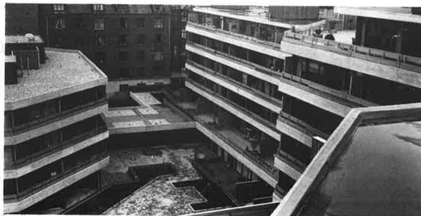
Alle lejligheder har en eller flere altaner eller terrasser (med udvendige stikkontakter).
