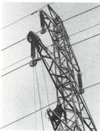
Luftledningsmontører fra afd. H. (se teksten side 2).
