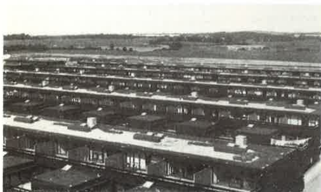
Projekt og montage Hvinningedalværket 1. etape. Silkeborg Kommune Filterkapacitet 2000 m 3 /h.
