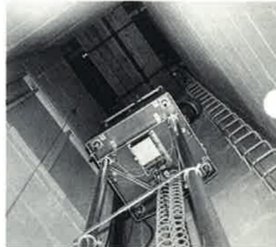
Montagearbejde i skakt. Air-liften med dens slangesystem og bærerør.
