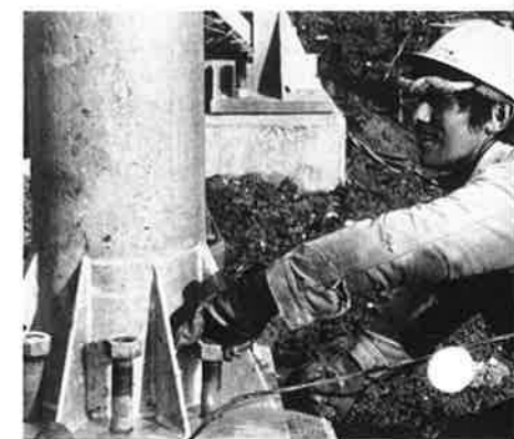
»Hovegård» Transformerstation. Hjælpe-montør Per Jørgensen efter-spænder master.
