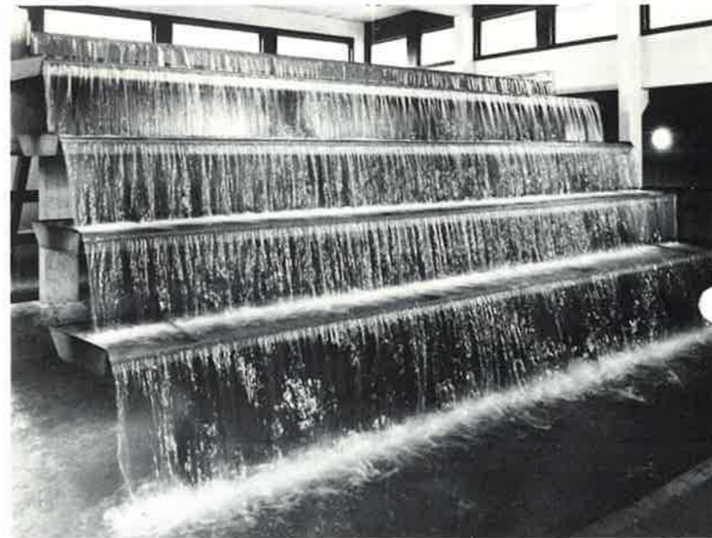
Iltningsstrappe, Ermelundsværket, afd. VTA.
