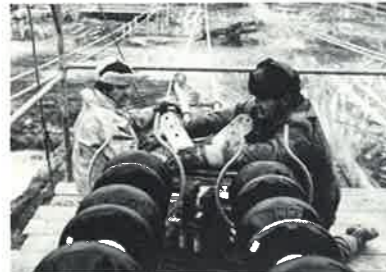
Montering af isolatorkæder på 120 kV samleskinne.
