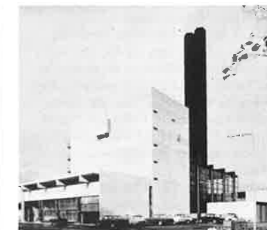
Horsholm Fjernvarme og Forbrændingsanstalt.
