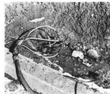
Første kabelbrud er fundet, men det var ikke det eneste. Her er man påny igang med målinger.
