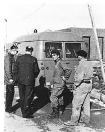
N.K.T.'s målevogn igang med at finde frem til hvor kablefejlen findes.
