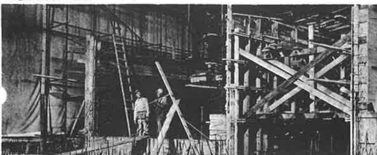
Den med 1000 m 2 presenning overdækkede byggeblok.
