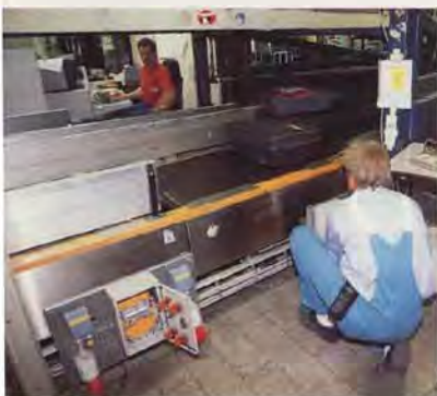
Ændring og programmering af styringer til bagagesorteringsanlæg
